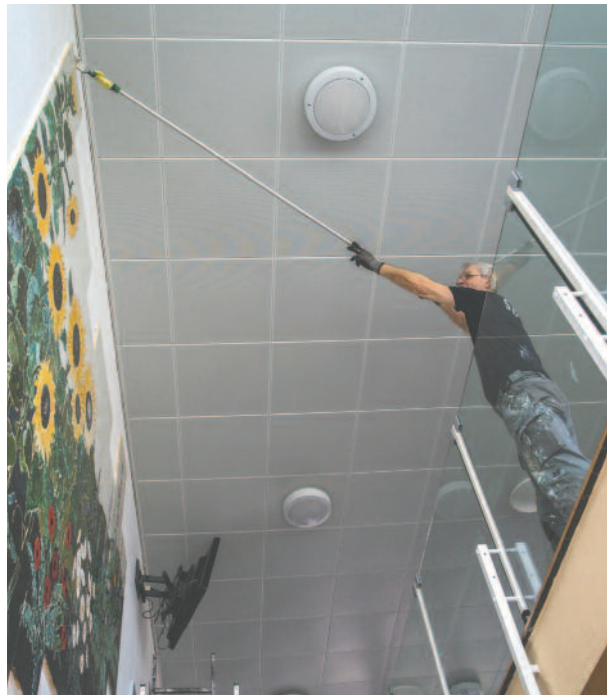
Auf dem Knivsberg sind die Renovierungsarbeiten in vollem Gange.
